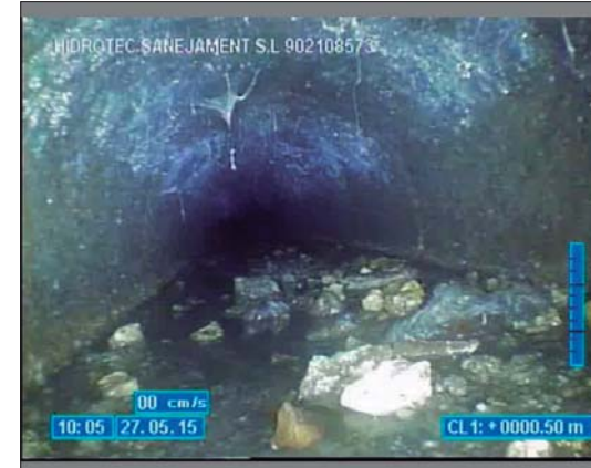
Foto: 8_8_28_A.JPG 0,5m, Aridos finos (por ejemplo, arena, cieno) en el hilo de agua, grueso Profundidad del depósito: 40 %
