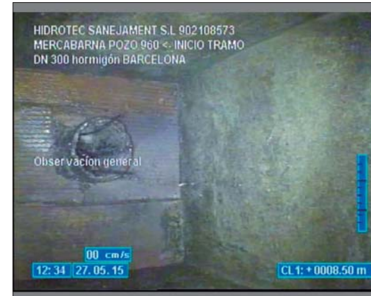
Foto: 14_14_48_A.JPG 8,5m, Observación general
