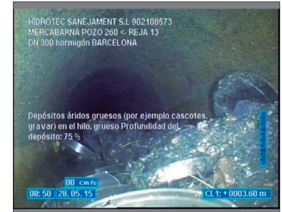
Foto: 24_24_88_A.JPG 3,6m, Depósitos áridos gruesos (por ejemplo cascotes, gravar) en el hilo, grueso Profundidad del depósito: 75 %
