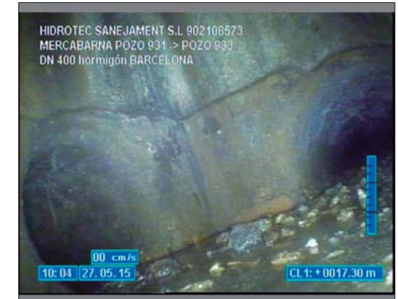
Foto: 7_7_26_A.JPG 17,3m, Micro-fisura longitudinal, anchura de la fisura Anchura de la fisura: 10 mm, a 10 h.
