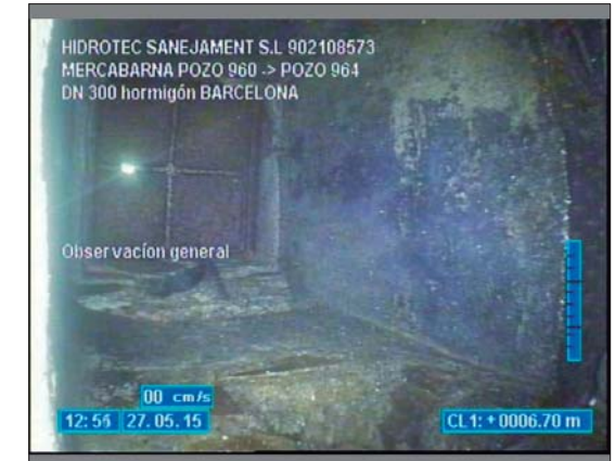
Foto: 15_15_54_A.JPG 6,7m, Observación general
