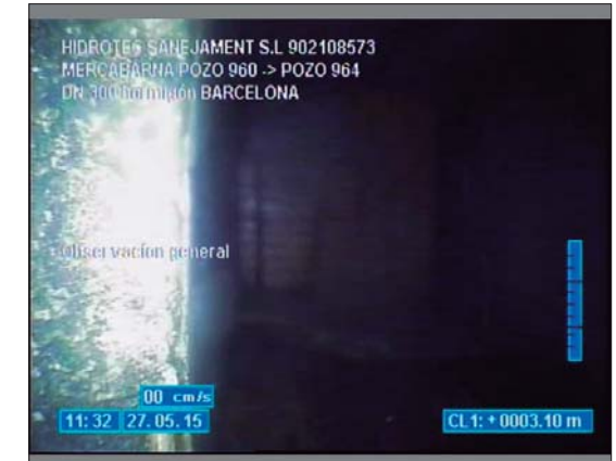
Foto: 9_9_45_A.JPG 3,1m, Observación general
