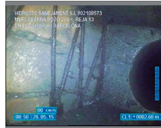
Foto: 24_24_87_A.JPG 2,6m, Observación general
