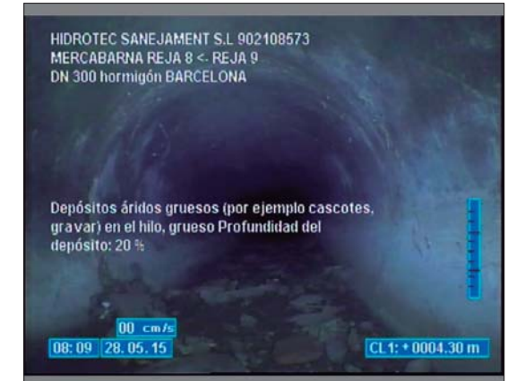
Foto: 18_18_65_A.JPG 4,3m, Depósitos áridos gruesos (por ejemplo cascotes, gravar) en el hilo, grueso Profundidad del depósito: 20 %
