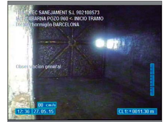
Foto: 14_14_50_A.JPG 11,3m, Observación general NUEVA NUMERACIONPOZO 960'
