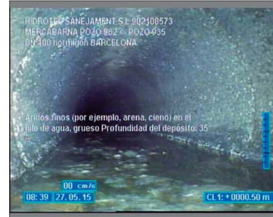
Foto: 2_2_10_A.JPG 0,5m, Aridos finos (por ejemplo, arena, cieno) en el hilo de agua, grueso Profundidad del depósito: 35 %
