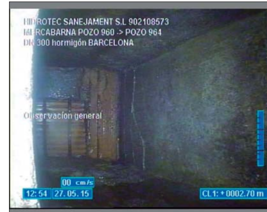
Foto: 15_15_53_A.JPG 2,7m, Observación general
